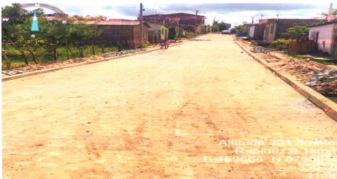
Execução de pavimentação Rua projetada 04
