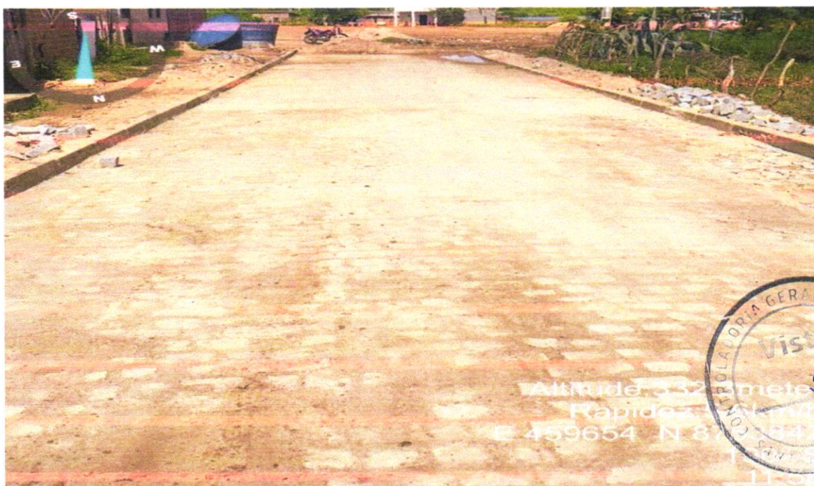
Execução de pavimentação Rua projetada 04
